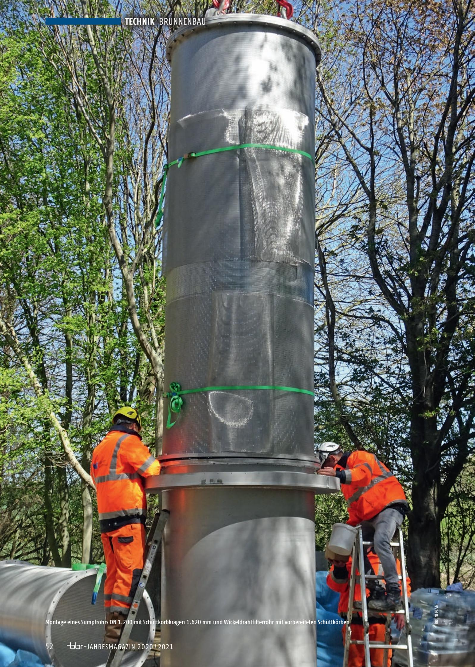
Montage eines Sumpfrohrs DN 1.200 mit Schüttkorbkragen 1.620 mm und Wickeldrahtfilterrohr mit vorbereiteten Schüttkörben
