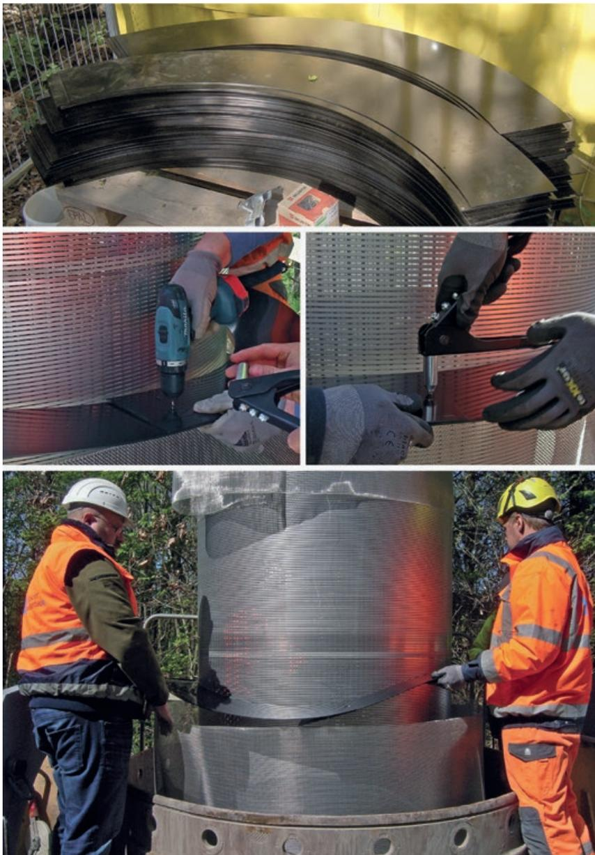
Abb. 6 – Montage und Einbau der Ringscheiben aus PE-Kunststoff
