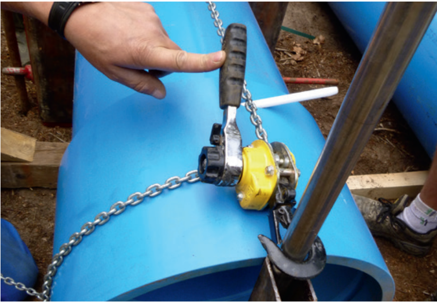
Abb. 6 – Vormontage der Noresta DN 400 Verbindung
