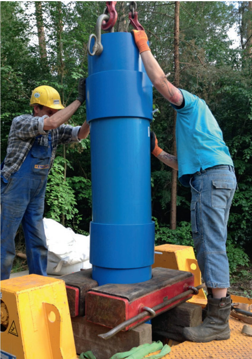
Abb. 7 – Setzen eines 1 m langen Vollrohrstückes
