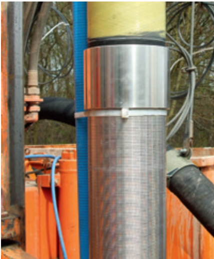
Abb. 2 – Kombiniertes Einbau eines Edelstahl-Wickeldrahtfilters mit GFK-Vollrohr
